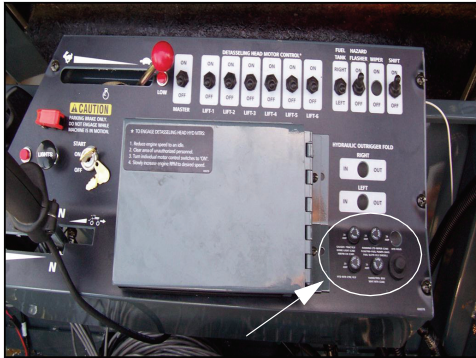
Fusíveis (Localizados no console lateral) -Vista típica
