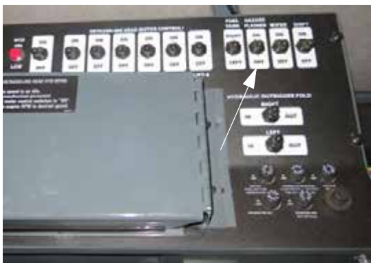
Переключатель аварийной сигнализации (расположен на боковой панели) – стандартный вид
