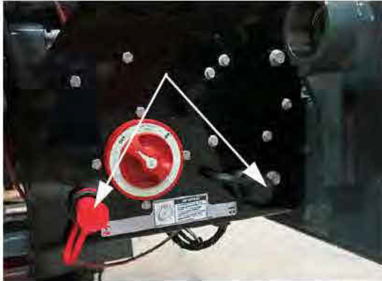
Bornes de carga auxiliar de la batería (ubicados en la parte posterior del chasis principal) -Vista típica
