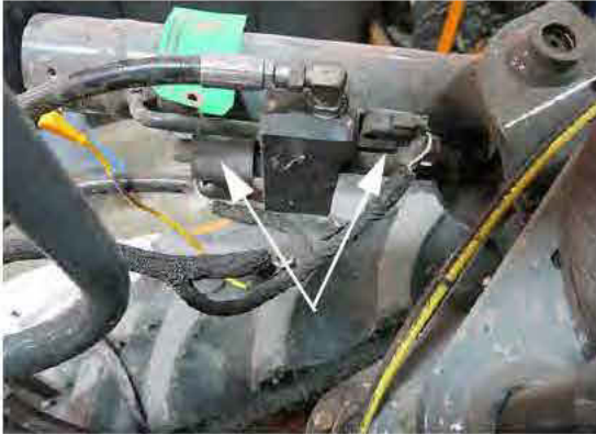
Válvulas de bloqueo -Vista típica
