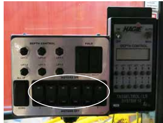
Interruptores de control del motor (ubicados en el panel de control de despenchado) -Vista típica
