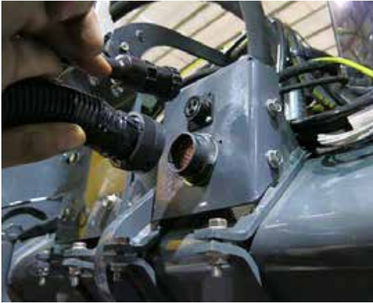
Conexiones eléctricas (en el lado derecho de la máquina) -Vista típica
