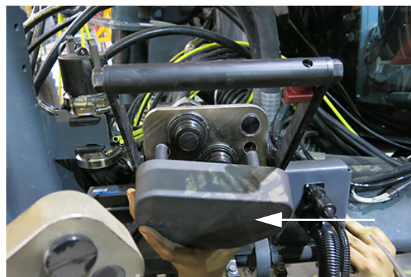
Couvercle de branchement hydraulique (côté droit de la machine illustré) - Vue typique
