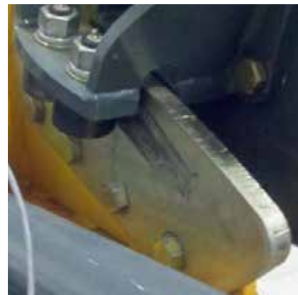
Dörzs tárcsa (a rögzített támasztómű, és a forgótengelyes támasztómű között helyezkednek el) – Tipikus nézet
