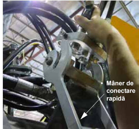
Ansamblu cuplaj multiplu hidraulic/electric (este prezentată partea stângă a utilajului) - Vedere tipică
