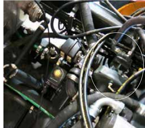
Насос для раствора (расположен рядом с центром машины) - стандартный вид * Вид с верхней части машины
