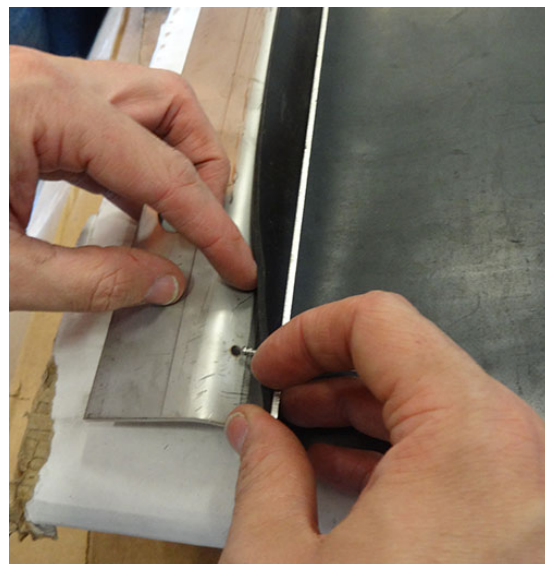
Súrolásvédelmi gumifüggöny szerelvény – Tipikus nézet
