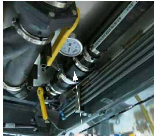
Áramlásmérő – Tipikus nézet
