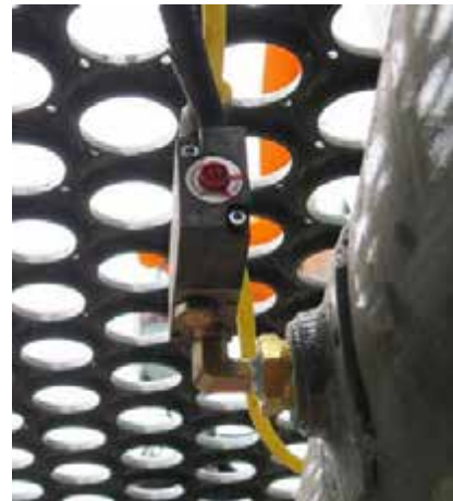
Elővezérlő szelep (elhelyezve a légtartály közelében) – Tipikus nézet
