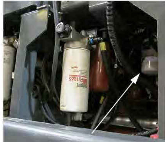
Filtre à huile moteur (situé le long du côté gauche de la machine - ouvrez le capot pour y accéder) - Vue typique
