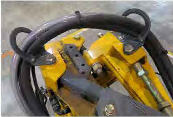
Installation d'un collier de serrage des tuyaux flexibles de la rampe - Vue typique
