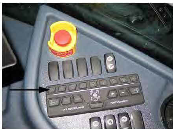
Interrupteurs des vannes de solution de la rampe - Pavé numérique de la section Produit unique, Sections 1 à 9 (situé sur la console latérale) - Vue typique
