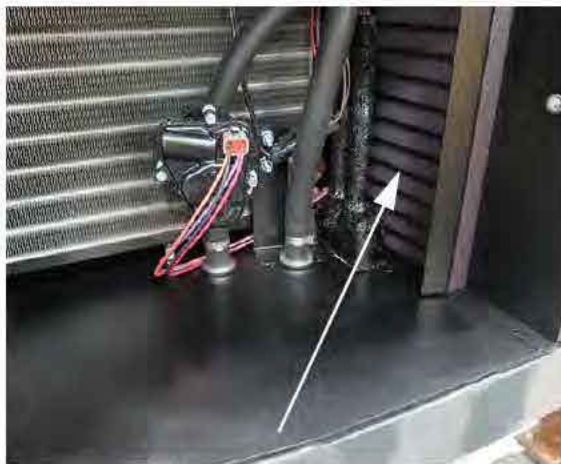
Filtre de recirculation (situé sur le côté droit du compartiment) - Vue typique
