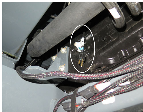
Motorblokk melegítő tápkábel - STS10/STS12 (a munkagép bal oldalán, a motor alatt található) – Tipikus nézet
