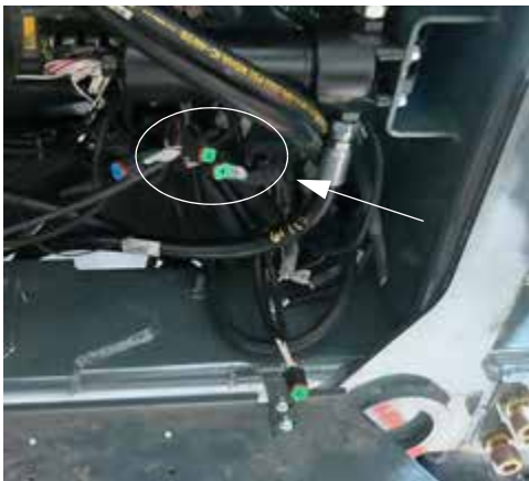
Videokamera bemenet csatlakozók (Fülke alatt - az első panel levételével férhet hozzá) – Tipikus nézet
