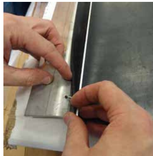
Súrolásvédelmi gumifüggöny szerelvény – Tipikus nézet
