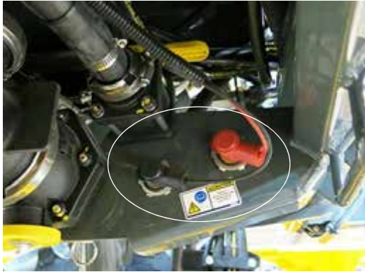
Táp csatlakozások (elülső töltő összeszerelés közeliében van) – Tipikus nézet
