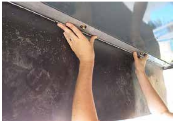
Súrolásvédelmi gumifüggöny telepítés – Tipikus nézet
